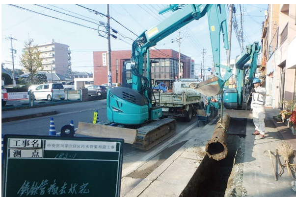
老朽管撤去状況
